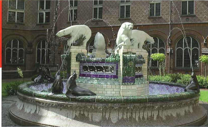
Ook de fontein is duurzaam gerestaureerd (foto's RACM, 2007)
