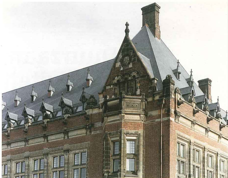
De nieuwe kap van het Vredespaleis in Den Haag. Tussen de dakkappen zijn daklichten aangebracht, die vrijwel niet opvallen. HENK DE GRAAF
