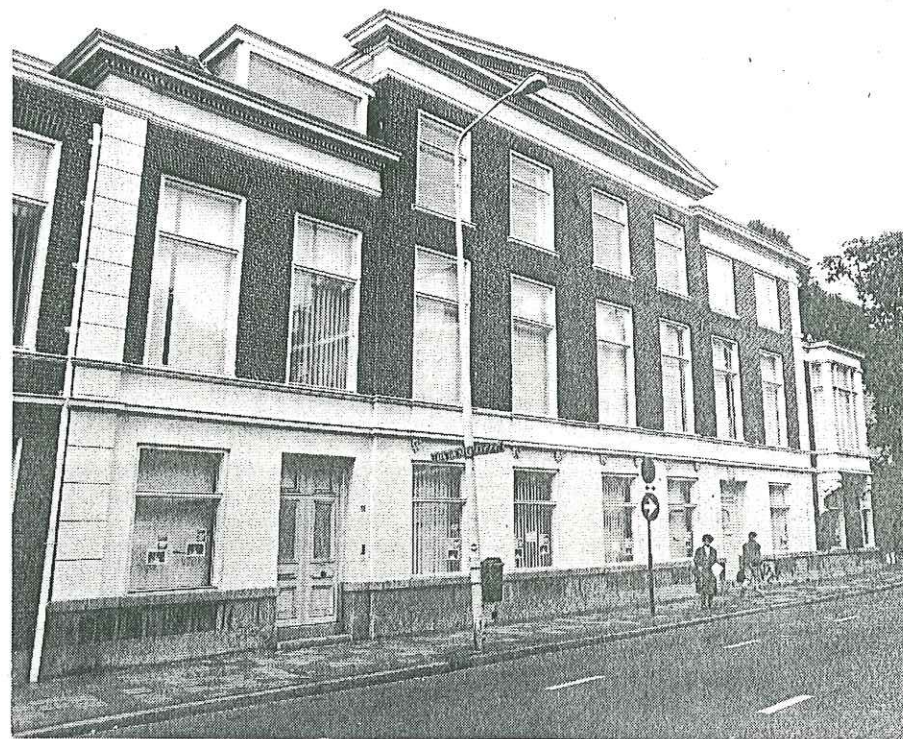
Het voormalige woonhuis van H. W. Mesdag aan de Laan van Meerdervoort, dat bij het museum wordt getrokken. Foto Archief/Sijthoff Pers
