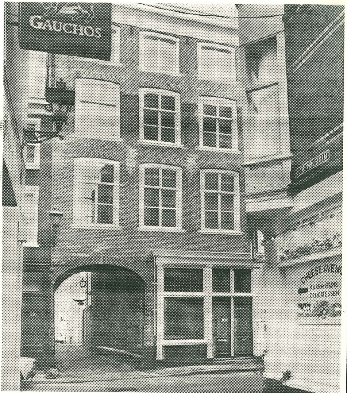
„De Koningspoort”, het opvallende pand aan de Molenstraat, dat volledig is gerestaureerd.
