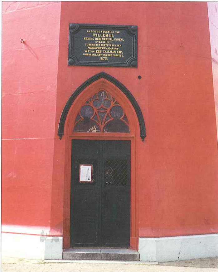
Toegang vuurtoren met gedenkplaat
