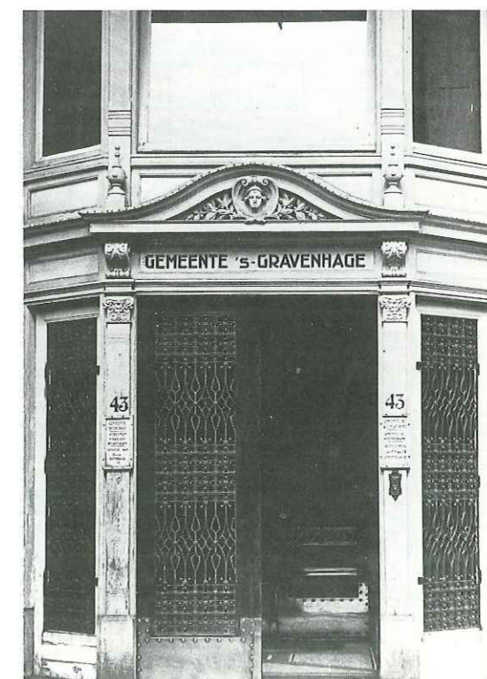
5. De entree uit 1910 met de vermelding van de in het pand gevestigde gemeentelijke afdelingen en diensten.
