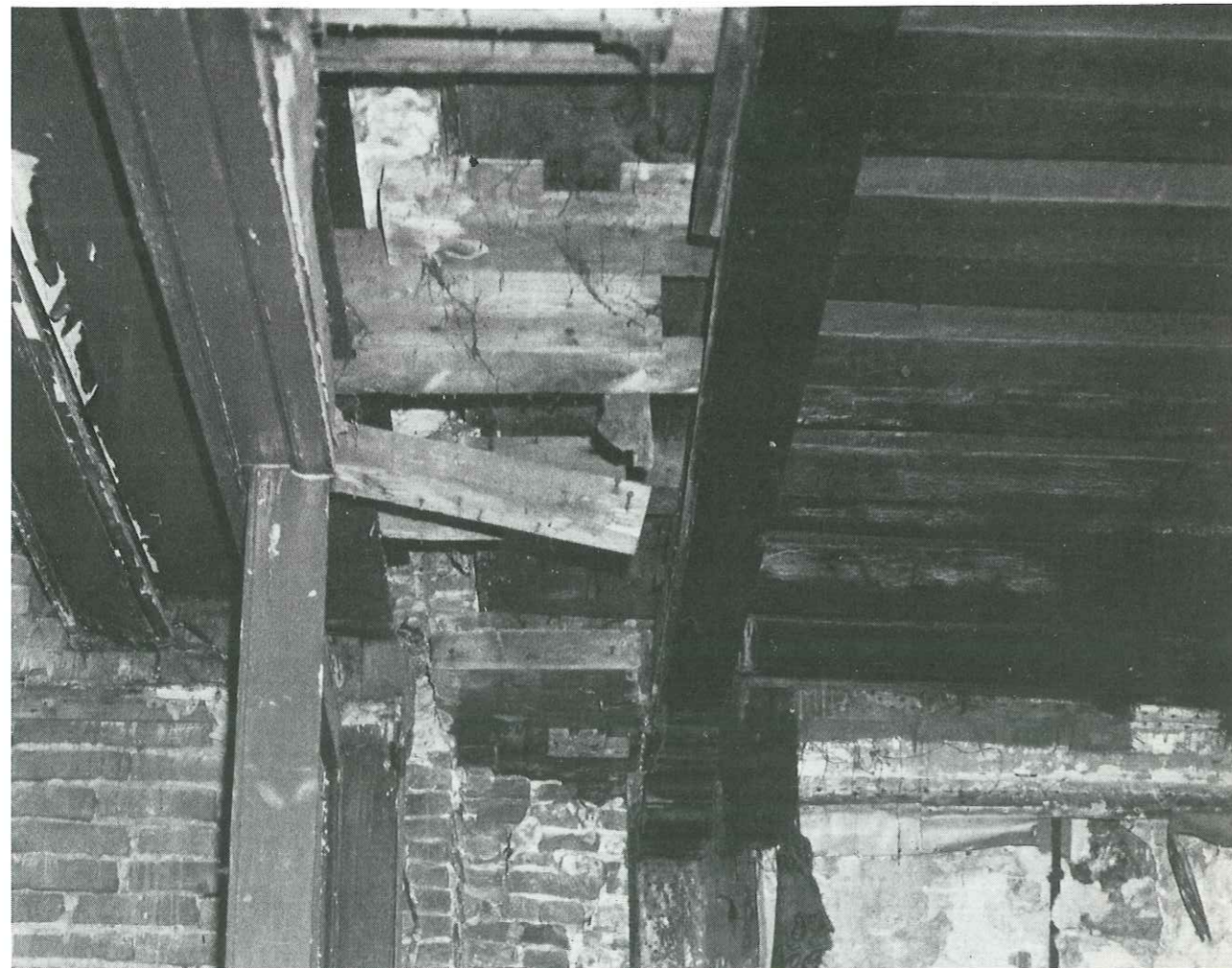
9. Aanhechting van het oude plafond aan de nieuwe achtergevel
