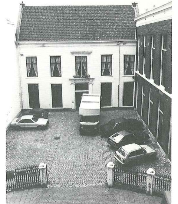
21. Nobelstraat 5, het Venduhuis. Hier is de 'basse-cour' nog steeds aanwezig
