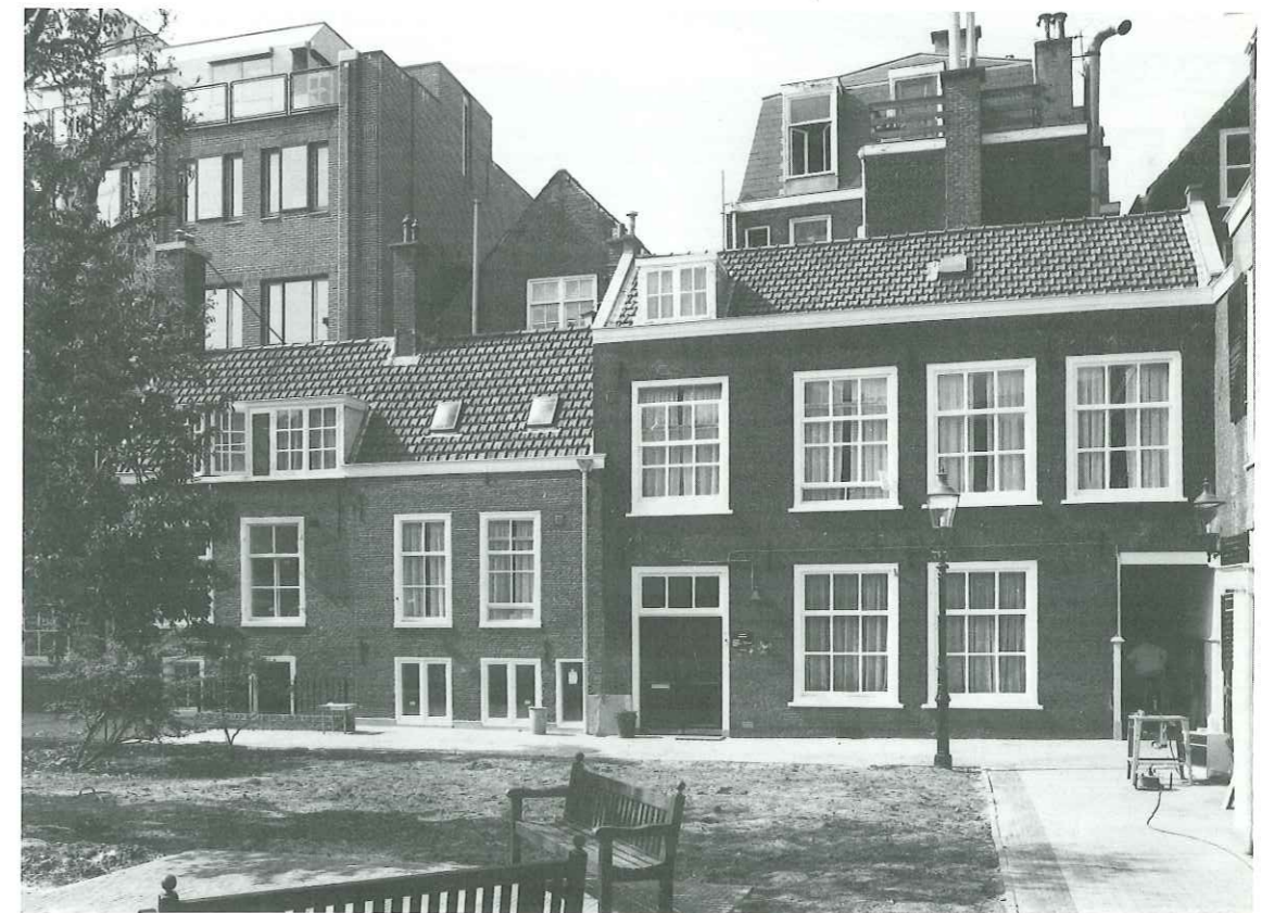
18. De vroegste bebouwing van de Rusthof. De hoge behuizing waarin de bestuurskamer is ondergebracht dateert uit 1841-1842. De aansluitende lagere woning is ouder maar werd voor het gebruik van de Rusthof grondig verbouwd (foto uit 1987)
