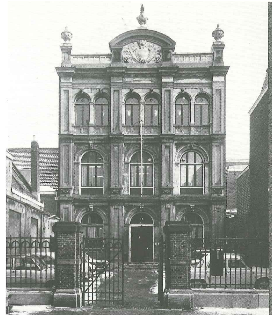
De voormalige Rijks H.B.S., Bleijenburg 38. Gebouwd in 1873 door de stadsarchitect W.C. van der Waeyen Pieterszen. Karakteristiek voorbeeld van het eclecticisme, dat doet denken aan de Venetiaanse renaissance.
