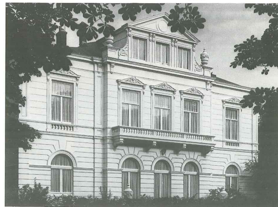
Plein 1813 3/3a, gebouwd in 1860 of 1861 naar het ontwerp van J.P.C. Swijser. Gebosseerd gepleisterde gevel met drie vensterassen brede middenpartij, bekroond door een attiekvormige dakkapel met fronton en siervazen op de hoeken. De parterre heeft rondboogvensters met op een doorgaande lijst rustende bogen, een motief uit het neoclassicisme. Een voorontwerp in het Gemeentearchief toont een afwijkende vormgeving, vooral ten aanzien van de dakkapel.
