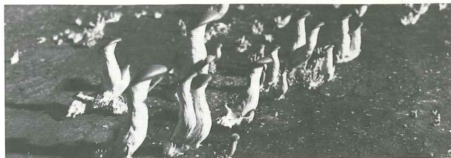
De gebouwen waren zo vochtig van het lekwater dat de zwammen door de isolatielaag op de vloerplanken heen groeiden.
