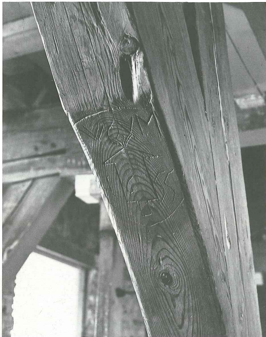
Sporen van de bouwgeschiedenis: het merkteken van een timmerman in een kapspant boven de poort van het Boterstraatje: WM 1655, met de schematische voorstelling van een olielamp.
