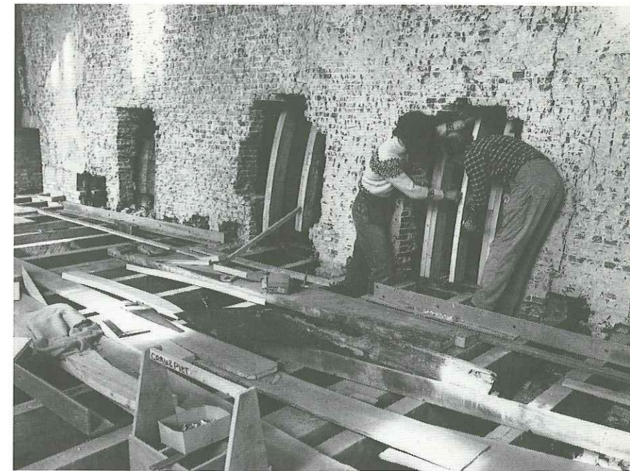
Om de gebogen spanten van de koepel te kunnen herstellen moesten gaten worden gemaakt in de omringende muren.
