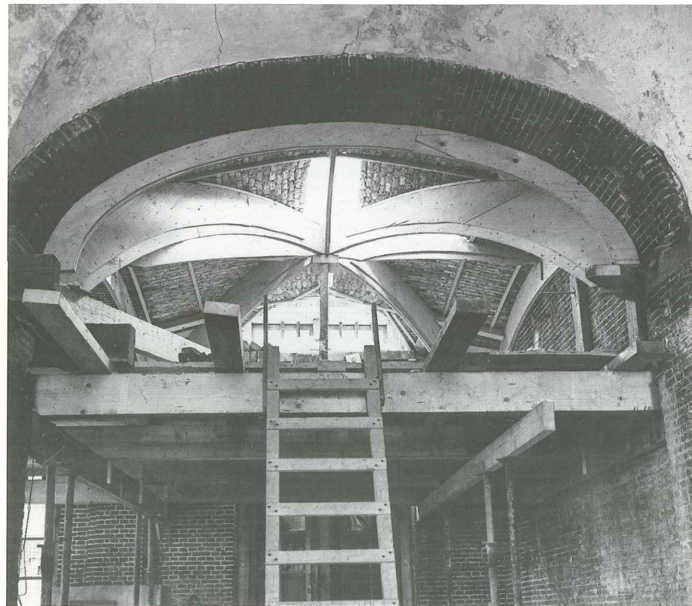
Op een tijdelijke hulpvloer in de galerij worden houten formelen geplaatst die de vorm aangeven en steun verlenen bij het opnieuw metselen van te zeer beschadigde gewelven.
