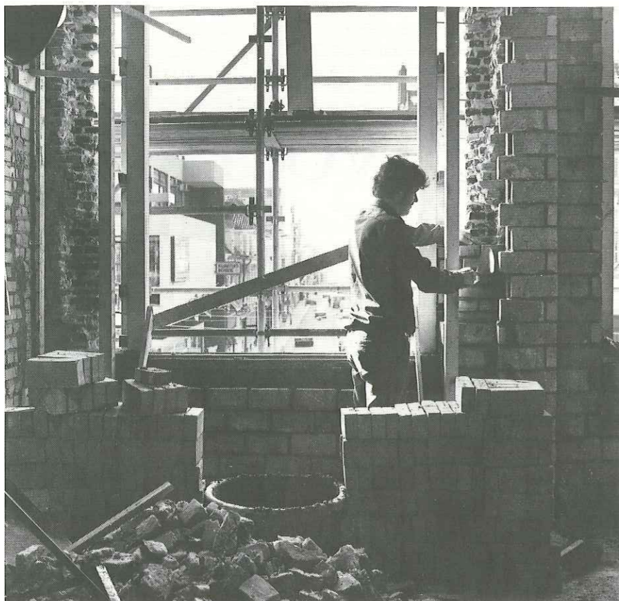
Het huis Luchtenburch, Prinsegracht 5, was ernstig aangetast door zwam. Nieuwe kozijnstijlen worden aangewerkt tegelijk met het op metselen van de binnenwanden.
