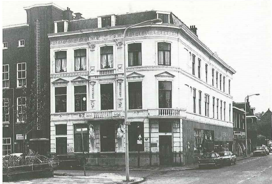
Helmersstraat 142/144/Elandstraat 194a. Dit witgepleisterde hoekpand is in 1881 gebouwd door de beeldhouwers Johan Hendrik Franciscus te Poel en Frederick Stephanus Stoltefus. De gevel aan de Helmersstraat heeft een rijke decoratie van in stucwerk uitgevoerde versieringen in aan de renaissance en het empire ontleende vormen. De derde vensters van links bezit een balkon, gedragen door twee hermen, de vensters daarboven worden geflankeerd door pilasters, tegen de eerste verdieping Ionisch en tegen de tweede verdieping Corinthisch. Vier van de vijf vensters in de eerste verdieping hebben frontons. Uit het empire afkomstig zijn het meanderfries tussen de eerste en de tweede verdieping en het fries met palmetversieringen onder de kroonlijst.
