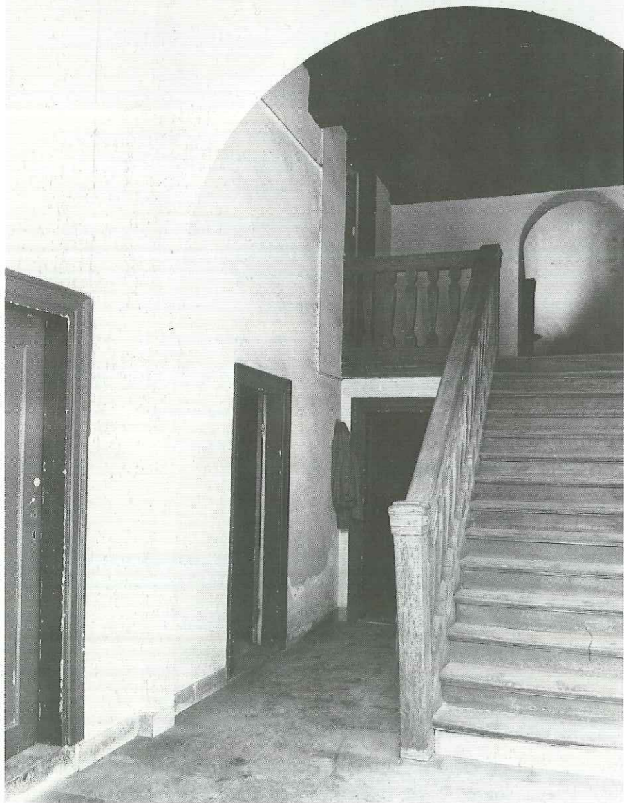
Waardevolle interieurelementen worden zorgvuldig gehandhaafd, zoals de brede eikenhouten trap in het oudste Waagegebouw, Prinsegracht 3, links van de poort. De foto is van vòòr de restauratie.
