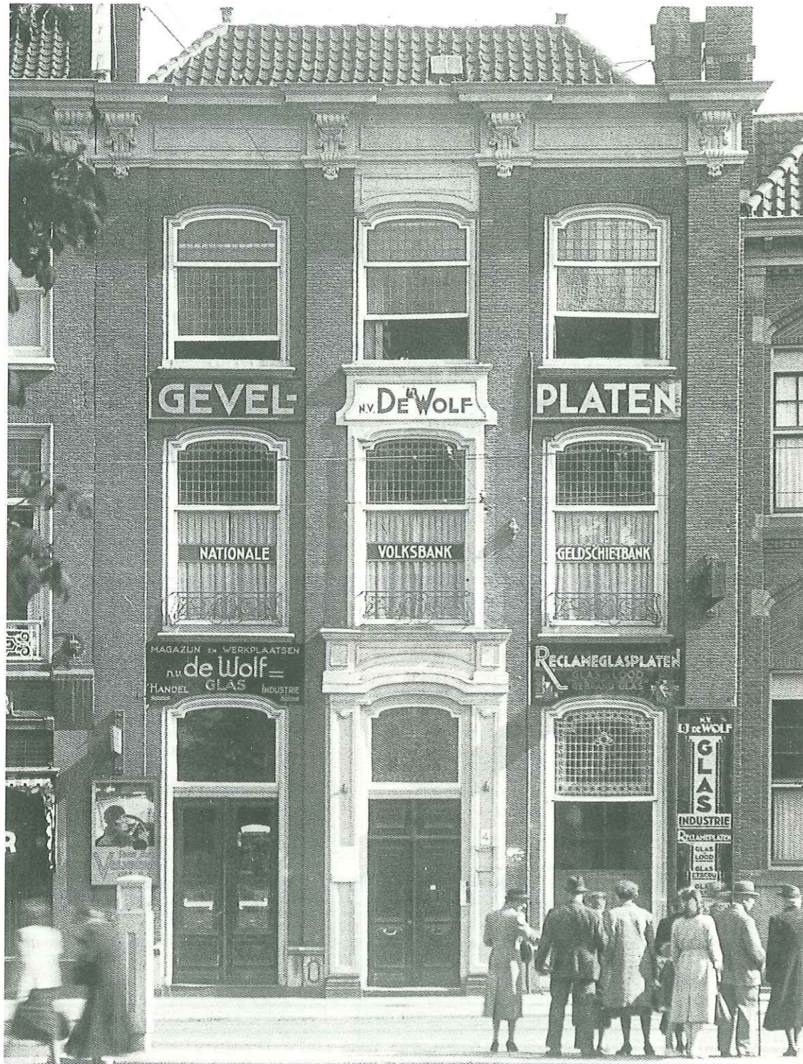
13. De voorgevel van het pand Riviervismarkt 4 in 1942.
