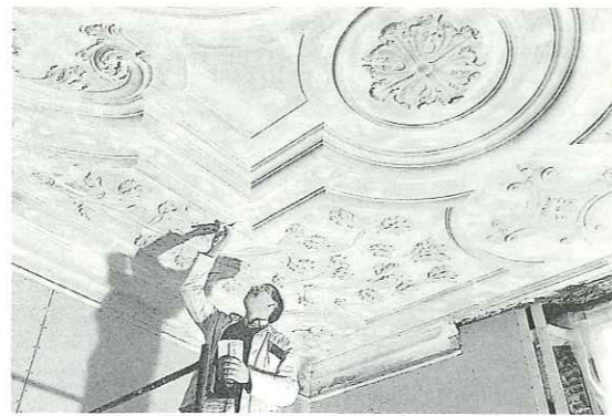
34. Restauratie van het plafond van de vergaderzaal Riviervismarkt 4.
