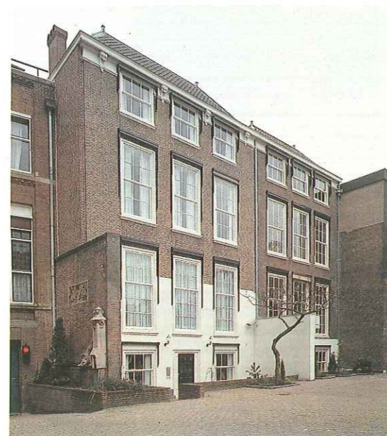
49. De achtergevel in de huidige toestand.
