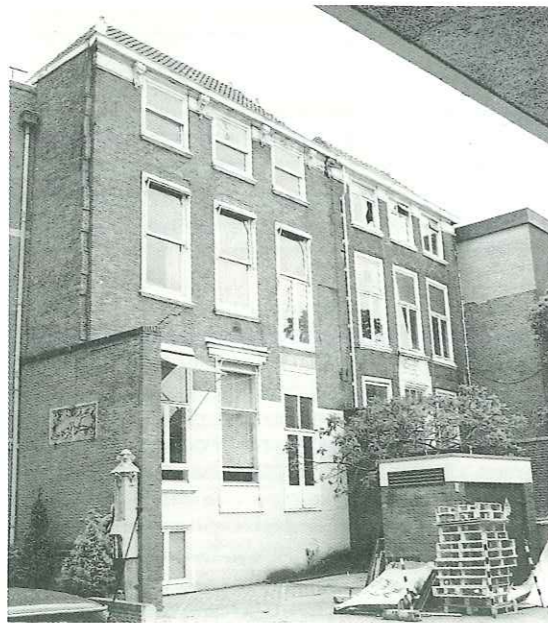
48. De achtergevel van pand Riviervismarkt 4 in oude toestand.
