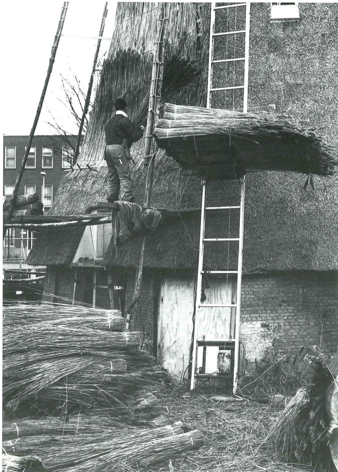
22. De rietdekker aan het werk, 11 februari 1987.
