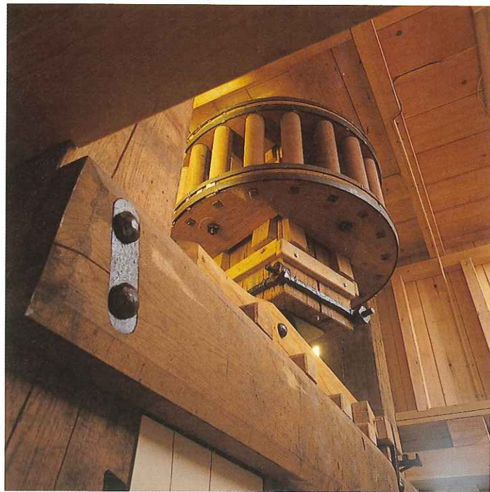
32. De onderzijde van de spil met de onderschijf, gezien vanaf de begane grond door vide, april 1988.
