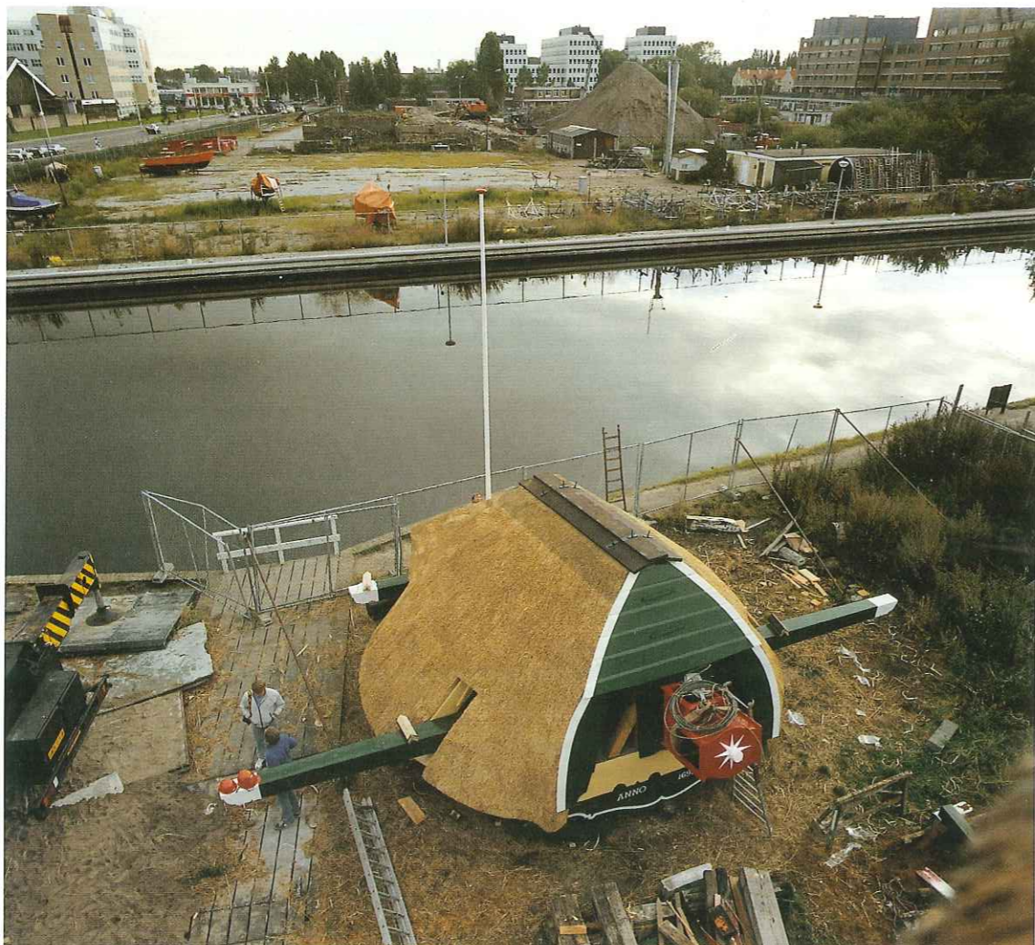
25. De kap gereed voor herplaatsing, 29 september 1987.
