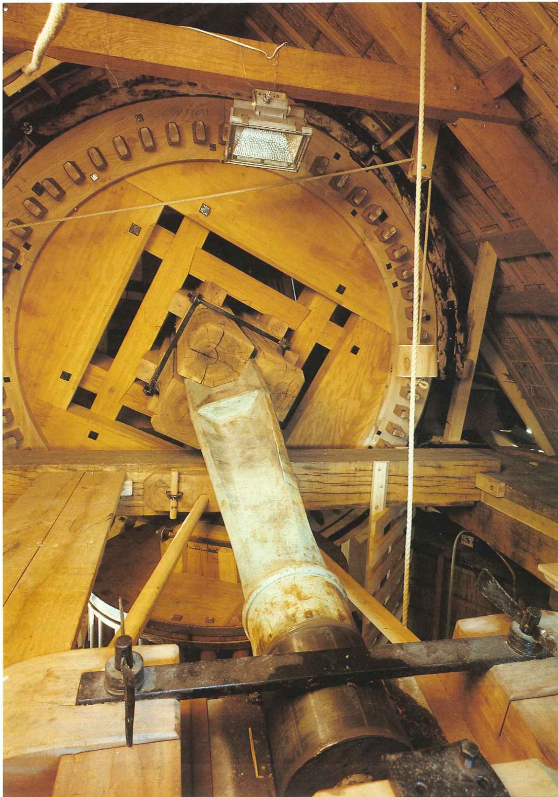
1a. Het interieur van de kapzolder, met de achterzijde van de bovenas en de bovenschijf, april 1988
