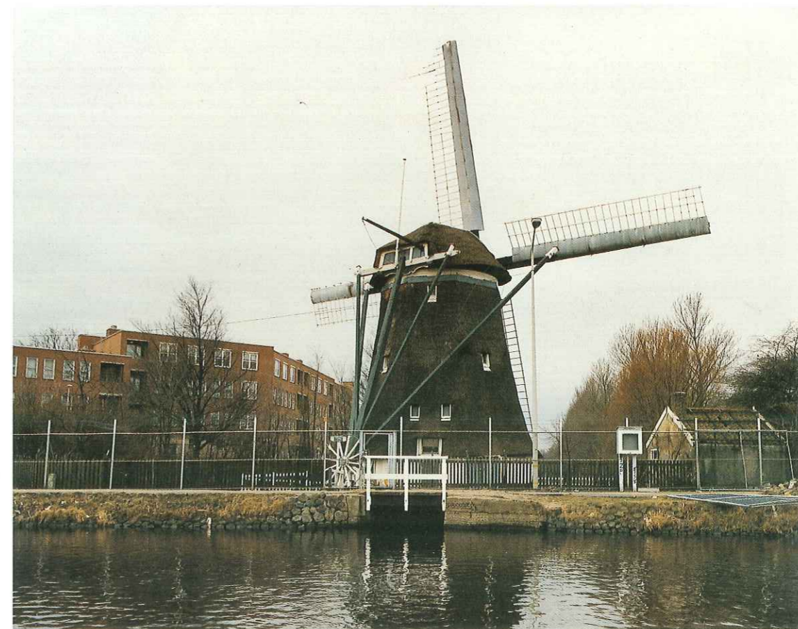
16. De Laakmolen voor de aanvang van de restauratie, februari 1983.
