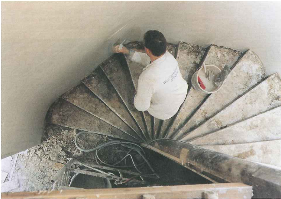
69. Spiltrap in de traptoren van de Korenbeurs. Toestand tijdens de restauratie.
