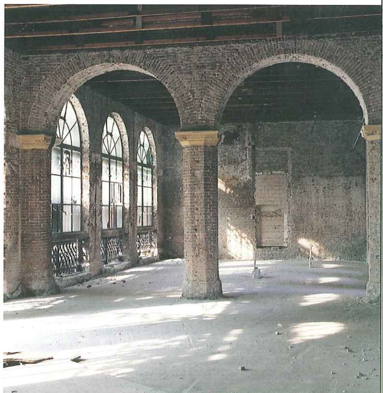
38. Beurshal. Toestand na de verwijdering van de bepleistering, 1991.
