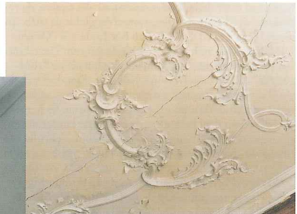
64. Detail van het Lodewijk XV-plafond voor de restauratie.
