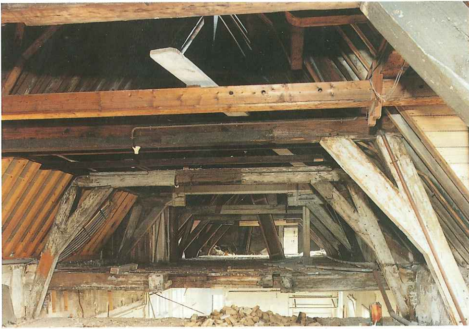
43. Zolderverdieping met de verhoogde balklaag. Situatie voor het terugbrengen op het oorspronkelijke niveau van 1662.
