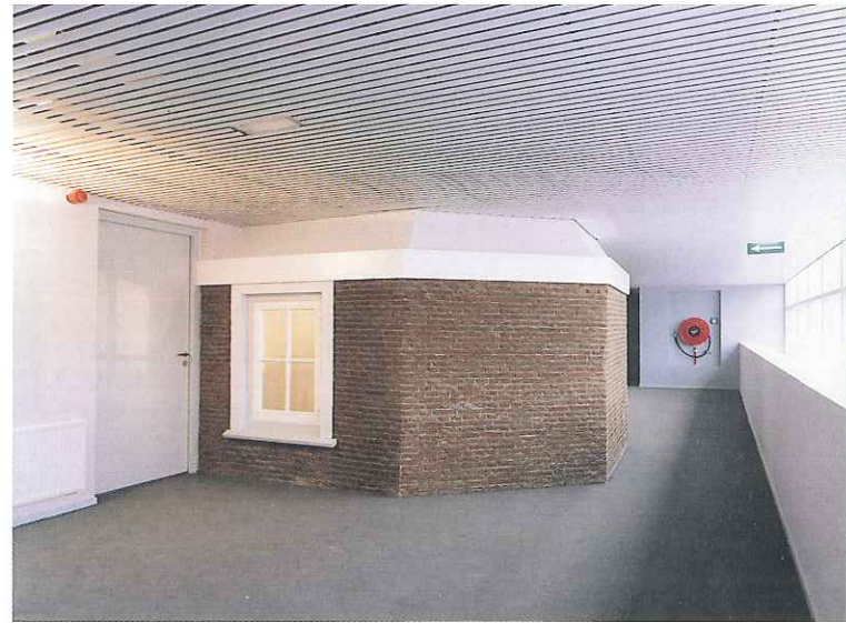
53. Bovenkant traptoren met oorspronkelijk metselwerk na de restauratie.
