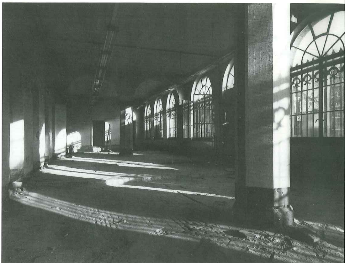
36. Beurshal. Toestand na de verwijdering van de houten vloer, jan. 1991.
