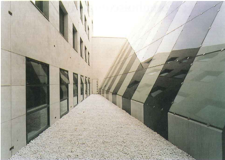
72. Extérieur van de aula. Links de nieuwe gevelwand tegen de achtergevel van de bestaande gebouwen.
