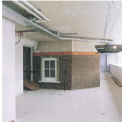
52. Bovenkant traptoren met oorspronkelijk metselwerk. Toestand tijdens de restauratie.
