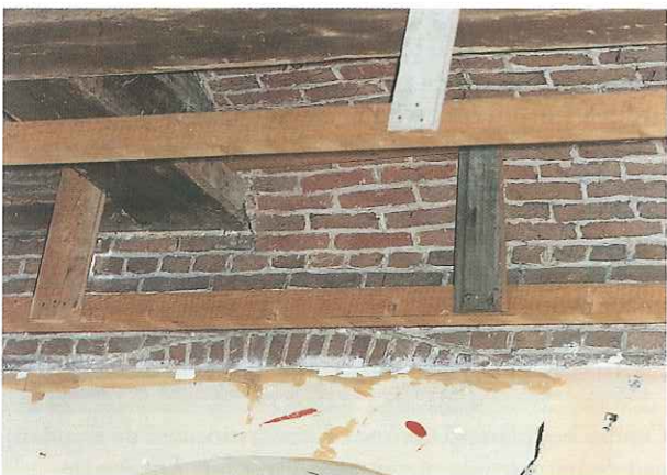
37. Beurshal. De vloer rondom de pijler is tot de fundering weggebroken. Toestand in 1991.
