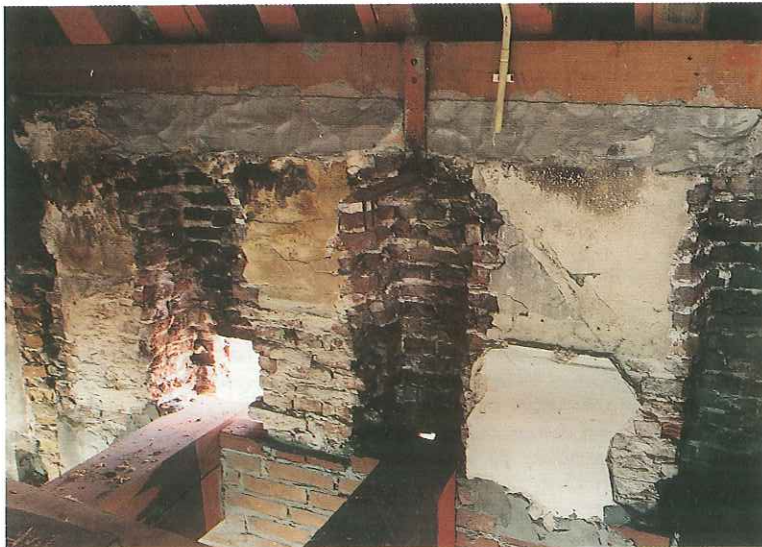
46. Zolderverdieping. Balklaag teruggebracht op het oorspronkelijke niveau. 1992.
