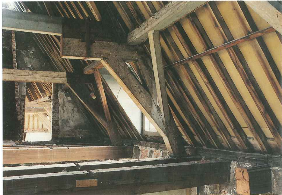
45. Zolderverdieping na de verwijdering van de blokkelen, kromstijlen en balken. Toestand van 1749-1991.
