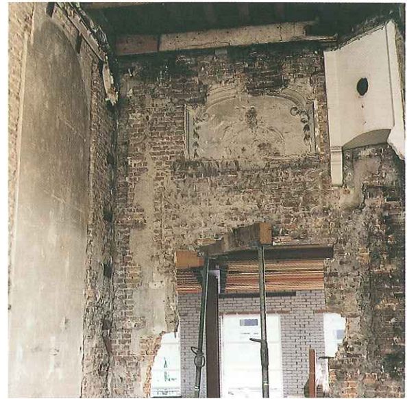
66. Oorspronkelijke hal met Lodewijk XIV-stucwerk. Tijdens de restauratie.
