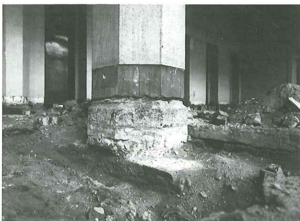
37. Beurshal. De vloer rondom de pijler is tot de fundering weggebroken. Toestand in 1991.
