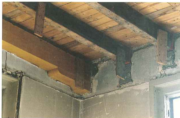
57. Pand nummer 2. Strijkbalk met sleutelstuk. Toestand voor de restauratie.
