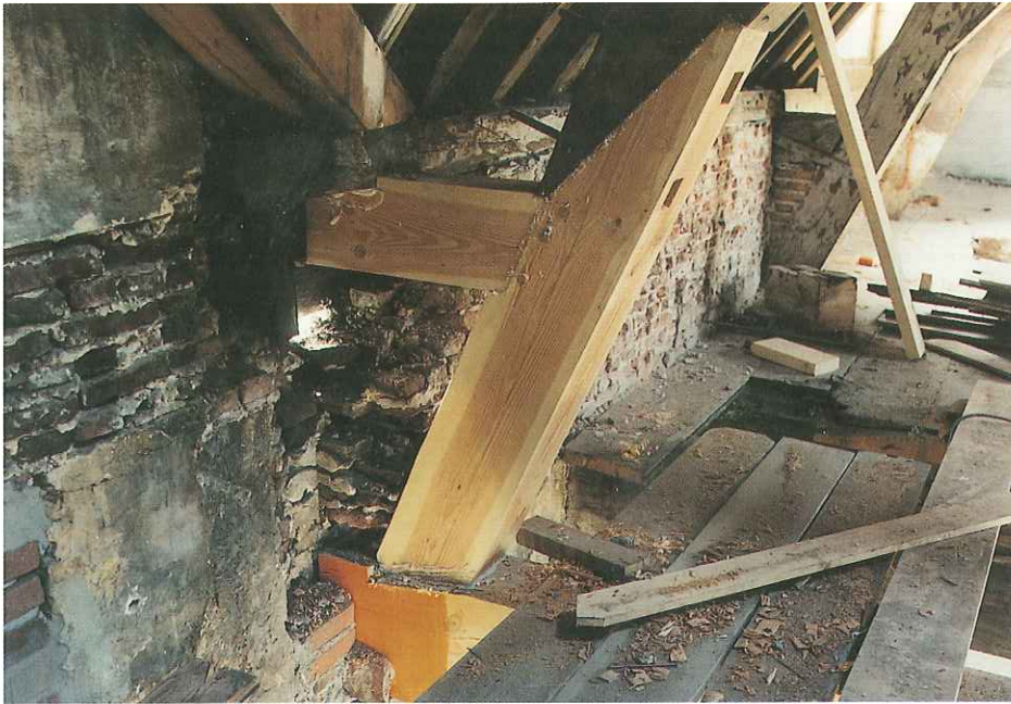
47. Herstelwerkzaamheden aan een kromstijl en blokkeel van de kap, 1991.
