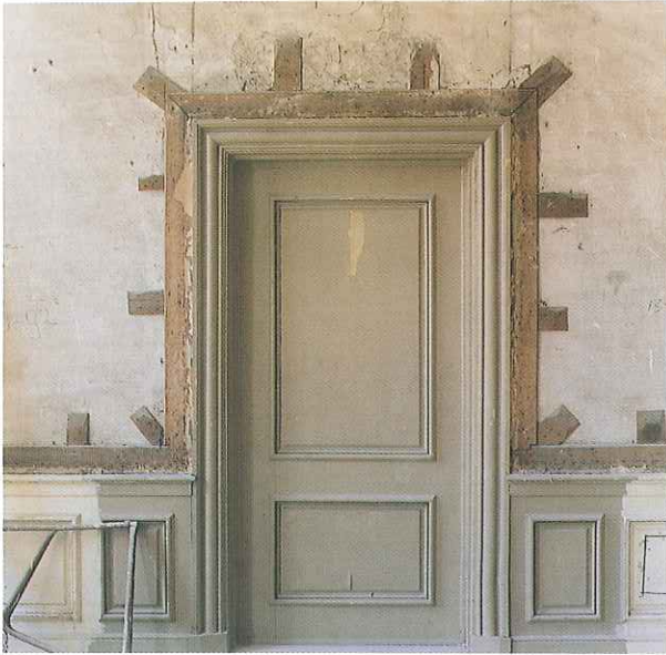
65. Pand nummer 4. Verbindingsdeur tussen de Lodewijk XV-stijlkamer en de oorspronkelijke hal. Tijdens de restauratie in 1991.
