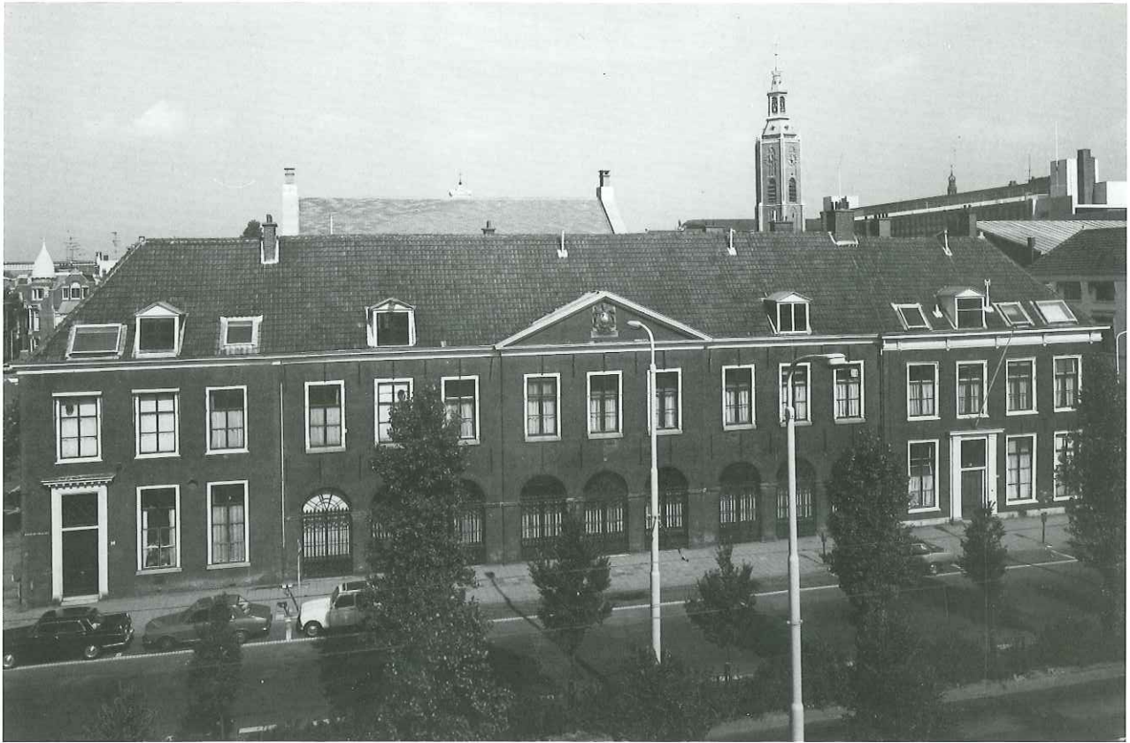
21. Gevel aan de Prinsegracht, het Kornhuyscomplex, toestand 1976.
