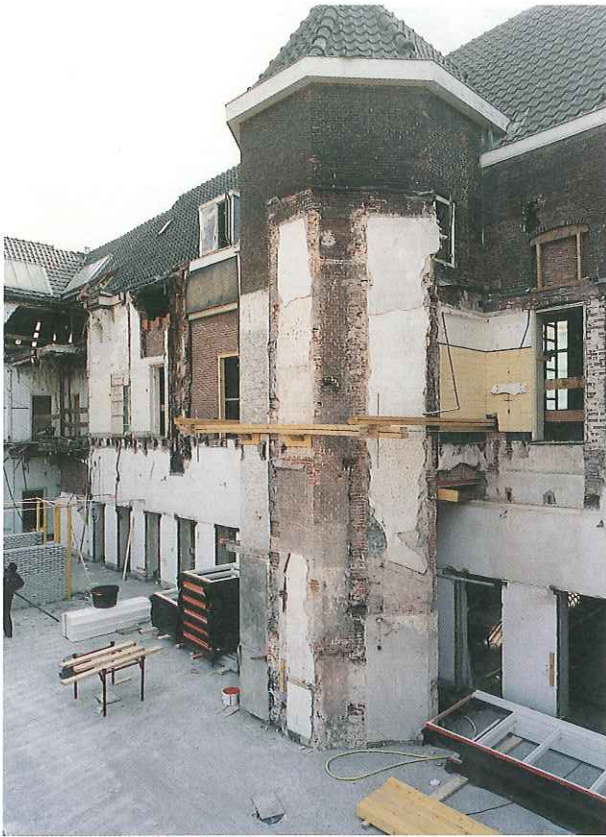
50. Traptoren vlak voor de restauratie.
