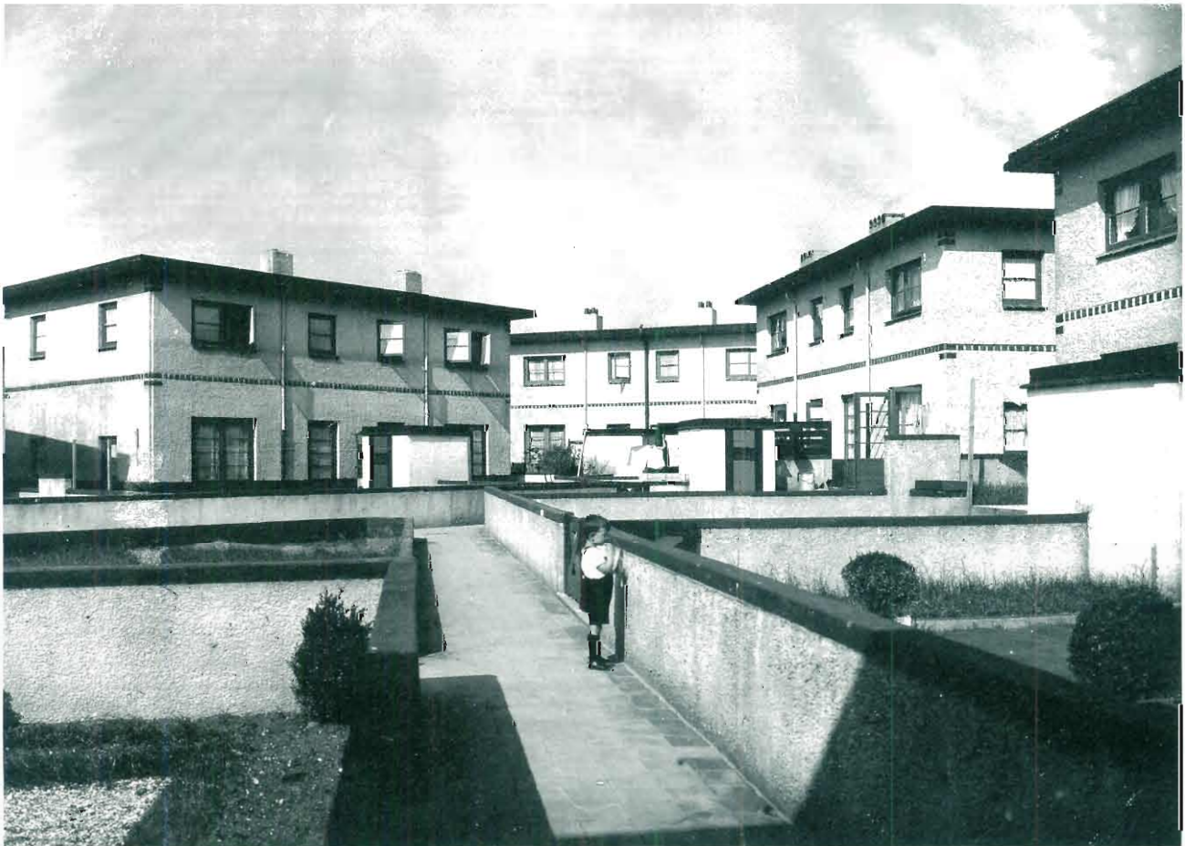
107. Achterzijden van de betonwoningen van W. Greve aan de Zalmstraat te Scheveningen (1923).
