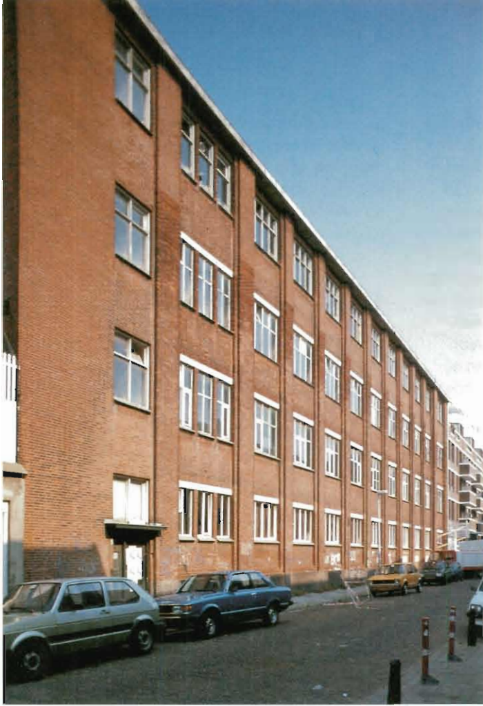
9. Mutters meubelfabriek in de Trompstraat te Den Haag.
