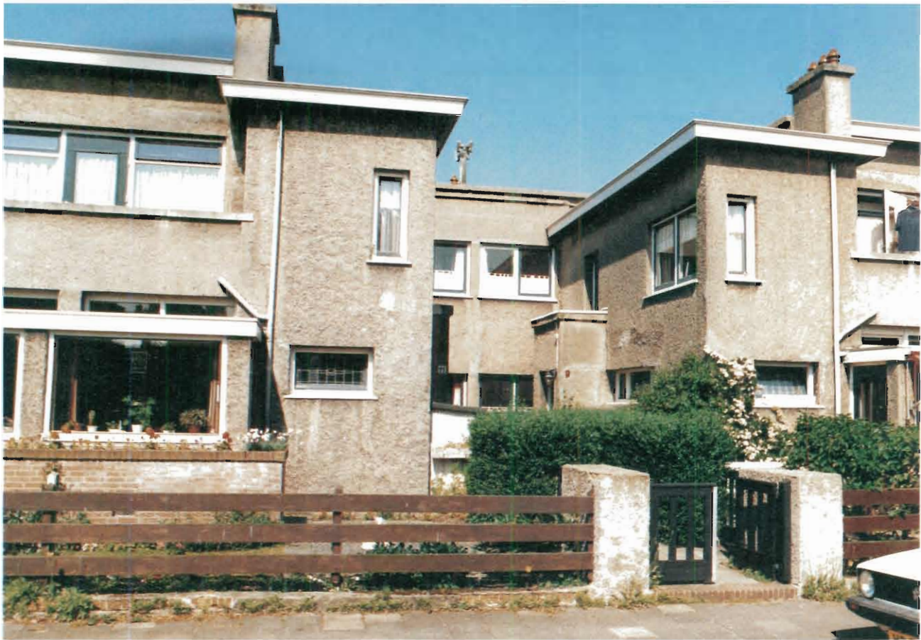
112. De tussen 1958 en 1969 aangebrachte dakoverstekken.
