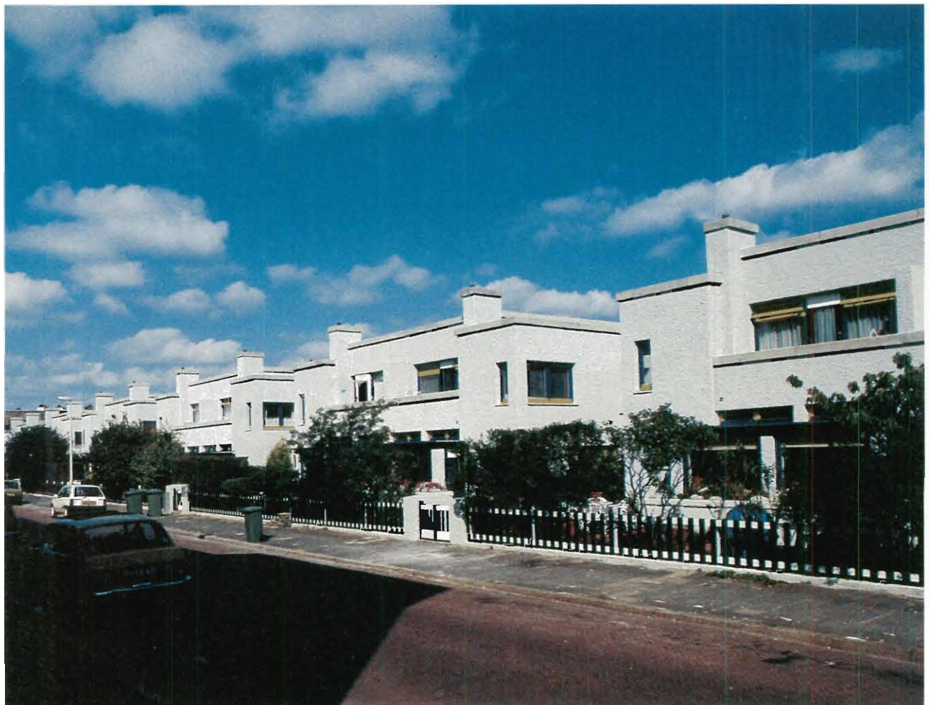
5. De Papaverhof: dubbele eengezinswoningen van het woningcomplex 'Tuinstadwijk Daal en Berg' in 1989.
