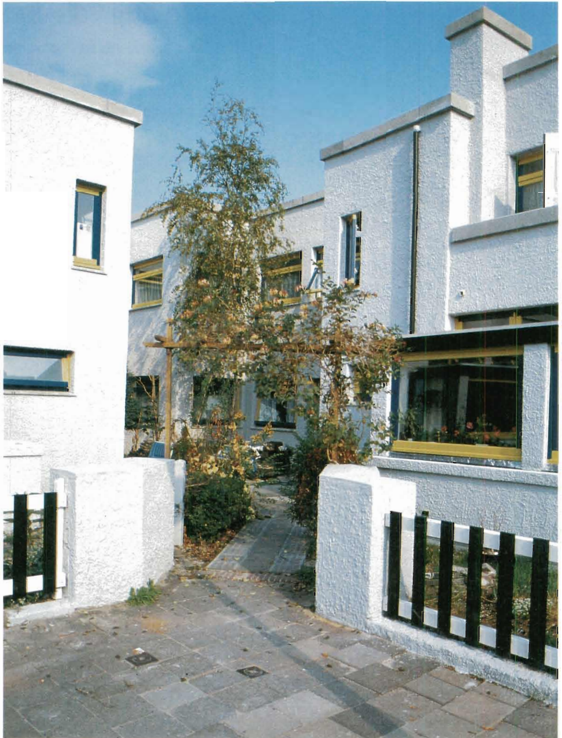
1. De Papaverhof na restauratie (1989).
