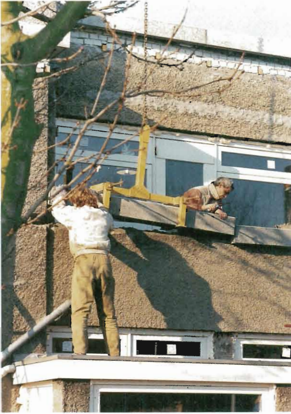
124. Aanbrengen van balkon- en dakranden.
