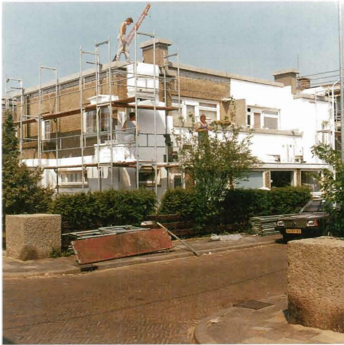
120. De gevelisolatie wordt aangebracht.
