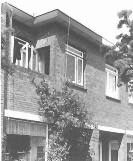
Kopie van het Bijvoet- en Duiker-raam op de verdieping van een blokje woningen aan de Primulastraat.
