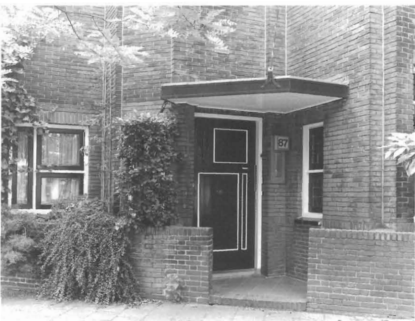
De overgang van straat naar tuin.
