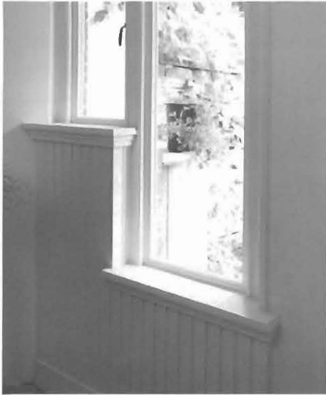
Binnenaanzicht van de ramen met de fraaie aftimmering. Links de gerestaureerde betimmering en lambrisering.
