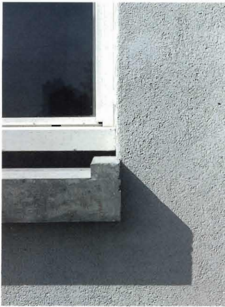
Detail van het nieuwe kozijn en de waterslag.
