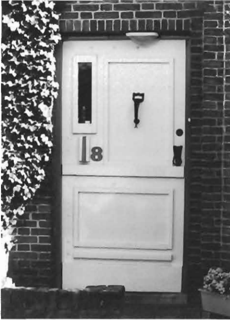
Voordeur van woonhuis Noordwijkselaan 8.
