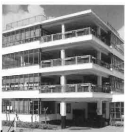
Openluchtschool Amsterdam Cliostraat Bijvoet & Duiker 1927-1930
