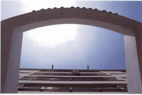
De luifel na verwijdering van het dak.
